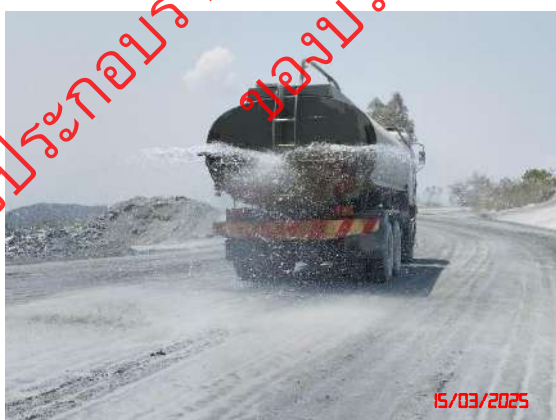
รูปที่ 16 การฉีดพรมน้ำบนเส้นทางขนส่งแร่
